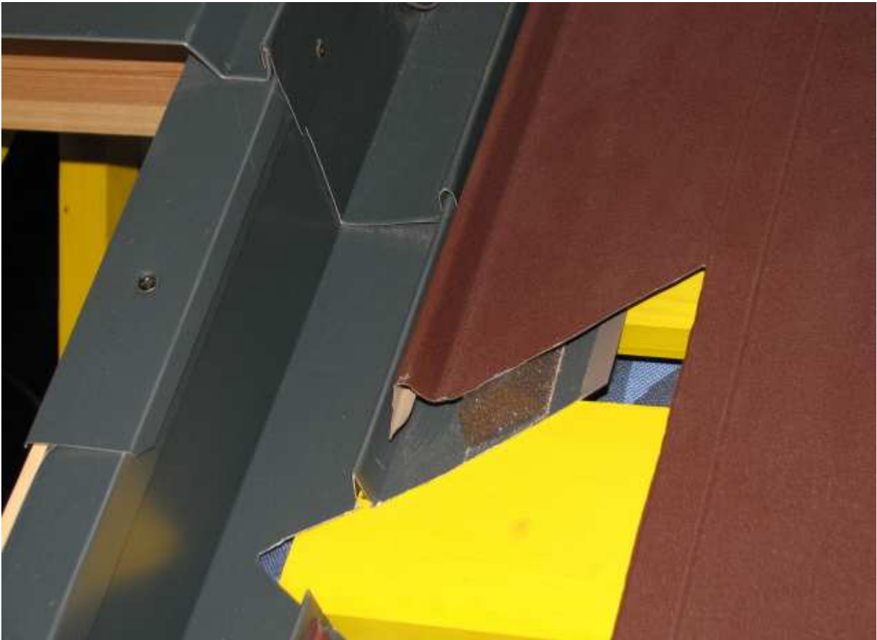
Obr.18 Bočné lemovanie a osadenie krytiny pri strešnom okne
