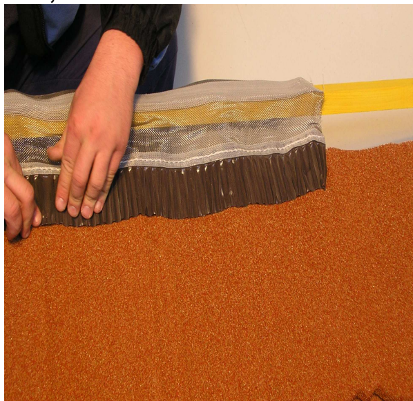
Obr.24 Upravenie lepiacej plochy na krytinu
