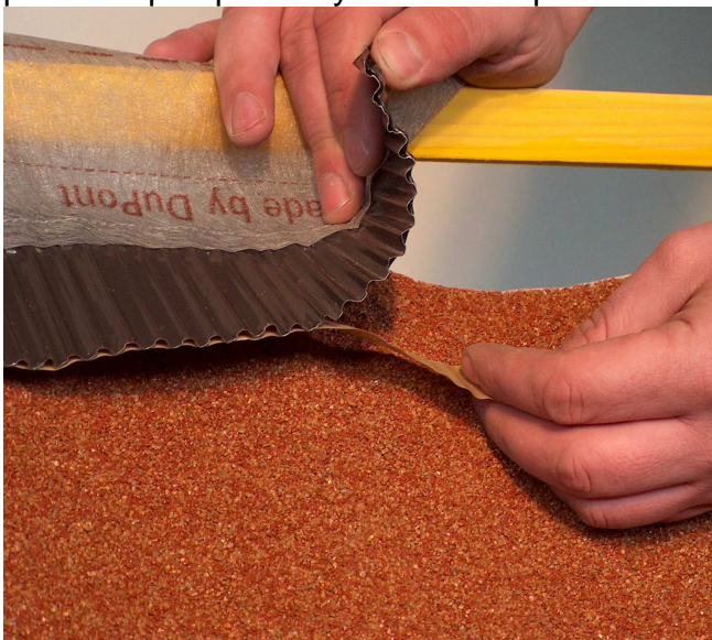
Obr.23 Lepenie vetracieho pásu ku krytine
