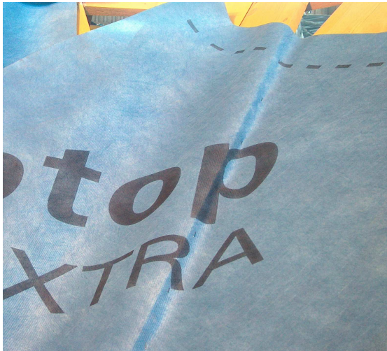
Obr.10 Priečne preloženie fólie sprava cez úžľabie
