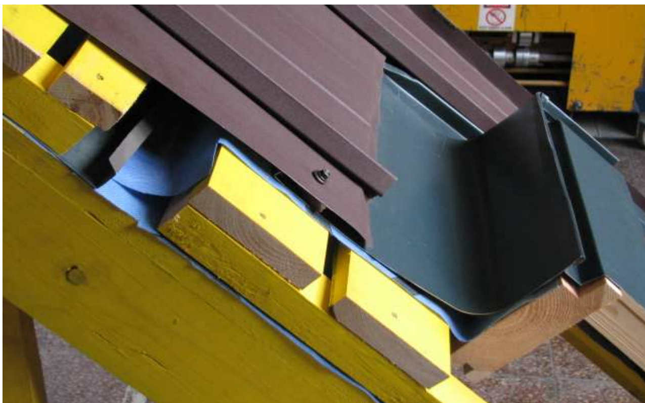
Obr.19 Rez horného ostenia strešného okna
