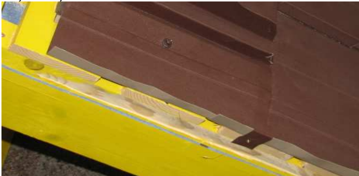
Obr.21 Detail vodnej drážky pri štítovej doske
