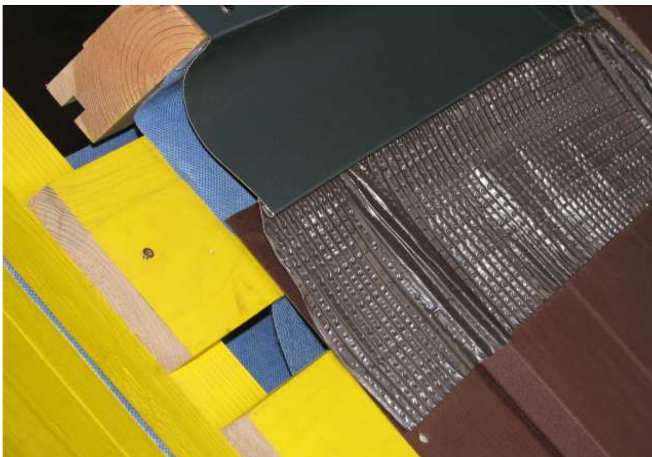
Obr.20 Úprava dolného ostenia strešného okna
