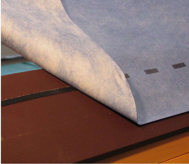
Obr.6 Podlepenie fólie na ODLF
