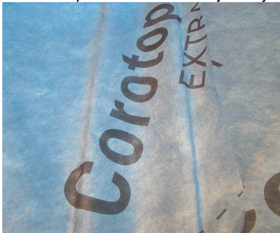
Obr.11 Priečne preloženie fólie zľava cez úžľabie
